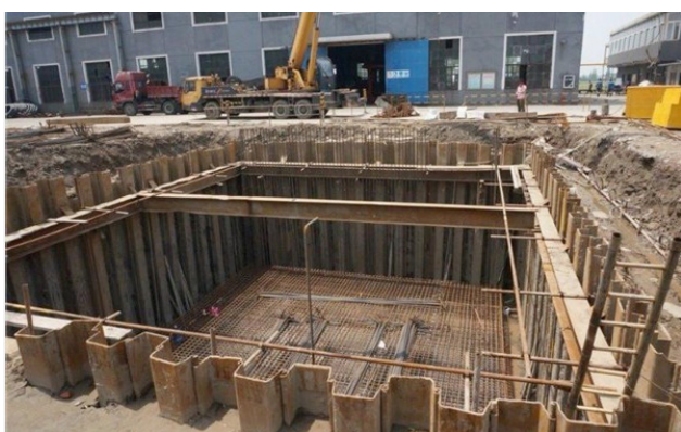
图1 地基基础施工
