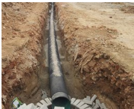
图1 市政工程中的现场地下管线施工
