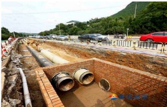
图2 市政工程地下管道安装
