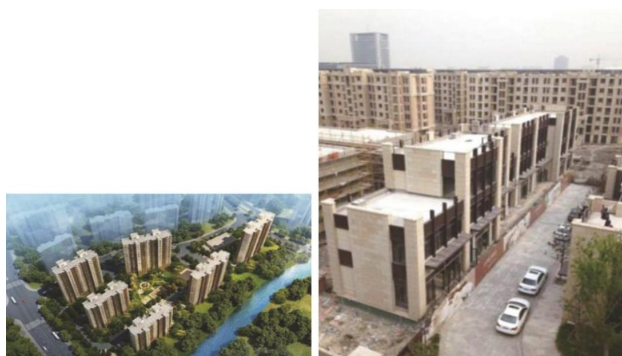
图1 装配式建筑项目工程
