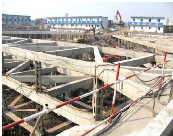
图1 住宅建筑深基坑围护结构
