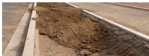
图4 种植土回填
