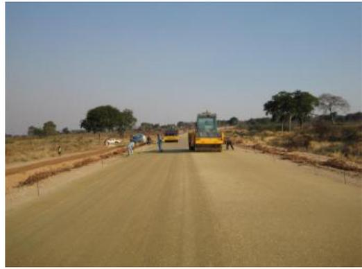
图1 公路压实施工现场图
