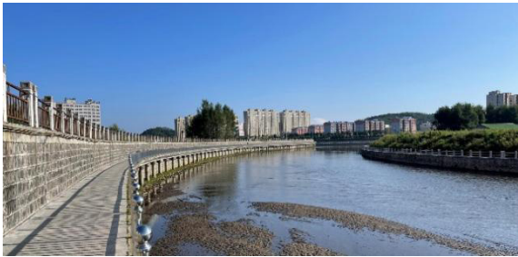
图 4 驳岸改造前现状照片
