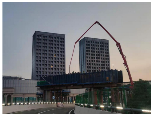
图 3.5-1 混凝土浇筑示意图
