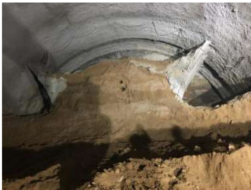
图 2 现场地质及施工过程中照片
