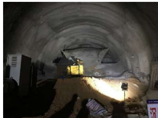
图 3 旋喷桩试桩施工
