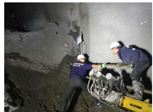
图 5 水平旋喷桩施工
