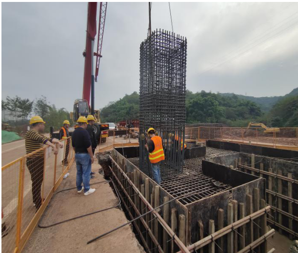
图8 墩柱整体吊装
