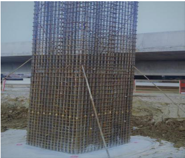
图 9 墩柱钢筋四角加固
