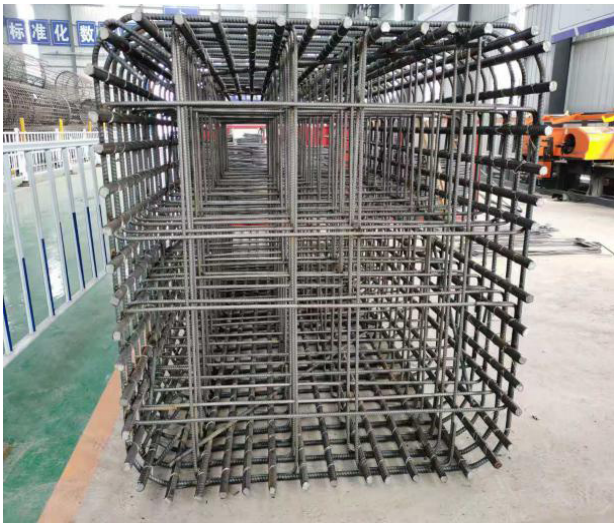
图7 墩柱钢筋场加工成型
