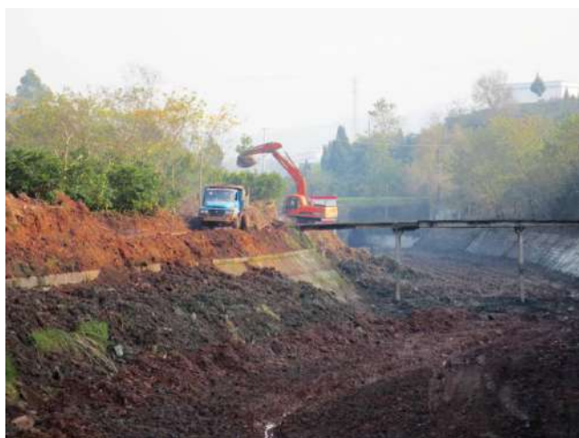
图2 人工渠道机械清淤
