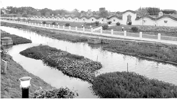
图1 河道水环境修复现状
