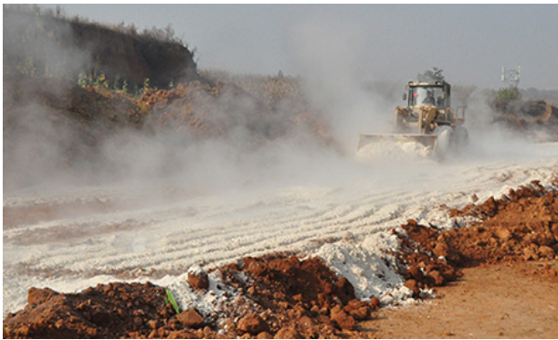
图1 施工过程中的扬尘污染
