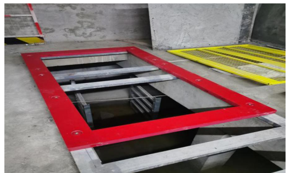
图5 改进安装结构的框架绝缘现场安装图
