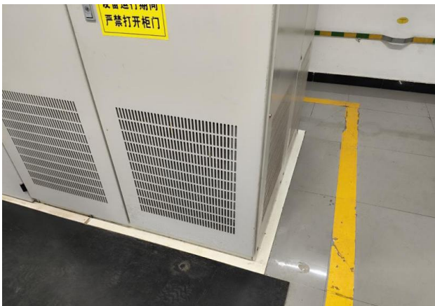
图2 现有直流系统柜体绝缘安装图
