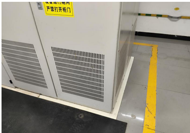
图2 现有直流系统柜体绝缘安装图
