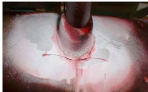
图 2 小口径管线连接处发生金属疲劳
