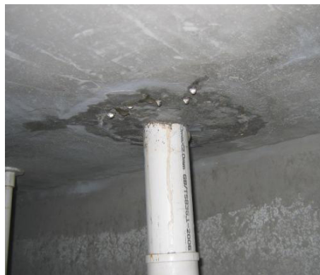
图1 卫生间渗漏示意图
