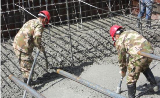
图2 建筑混凝土浇筑施工现场图
