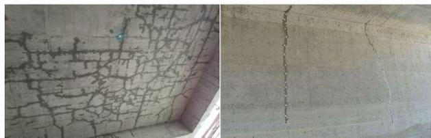
图 3 混凝土水化反应造成砼裂缝
