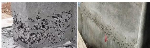
图 1 振捣不实造成的麻面
