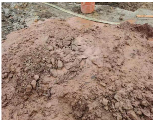
图 4 取出的松散回填钻渣
