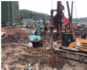
图9 多次反复回填黄土至孔口 图10 黄土回填后钻机施工
