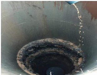
图 3 漏浆塌孔图
