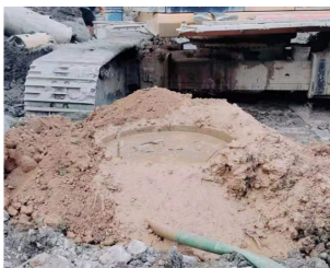
图9 多次反复回填黄土至孔口 图10 黄土回填后钻机施工
