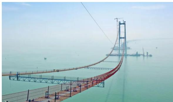
图1 猫道施工工程示意图
