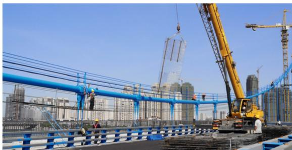
图2 猫道拆除现场示意图
