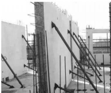
图1 预制剪力墙施工技术
