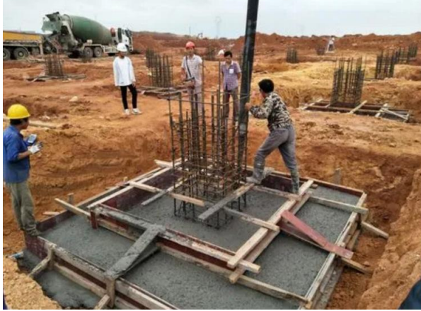
图1 建筑工程浇筑施工现场
