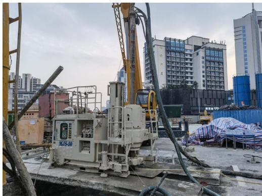
图3 MJS工法桩现场施工
