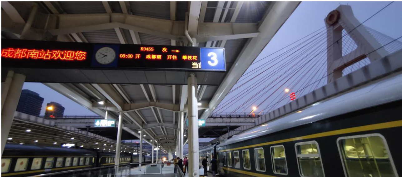
图1 成都南站跨过轨道和站台的城道路悬索桥(作者摄)
