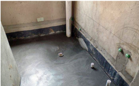
图 1 卫生间防渗漏施工
