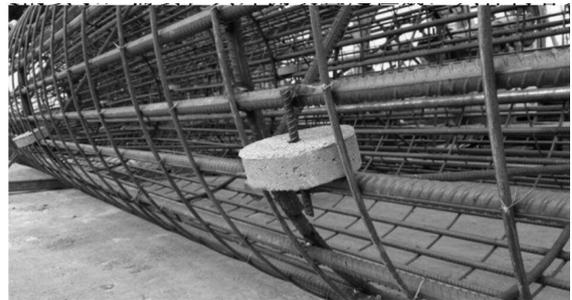
图2 钢筋笼的制作图
