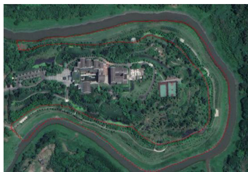
图 3 2017 年 4 月整体施工完成后航拍图
