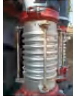
图 4 波纹膨胀节螺栓杆
