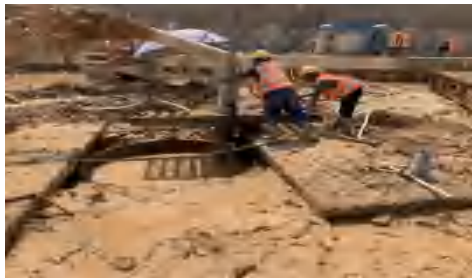
图2 气举反循环导管动态清孔
