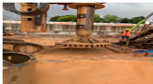
图1 大直径桩清孔刷刷底
