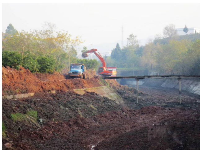
图 2 人工渠道机械清淤
