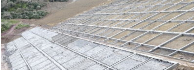
图1 大坝混凝土护坡
