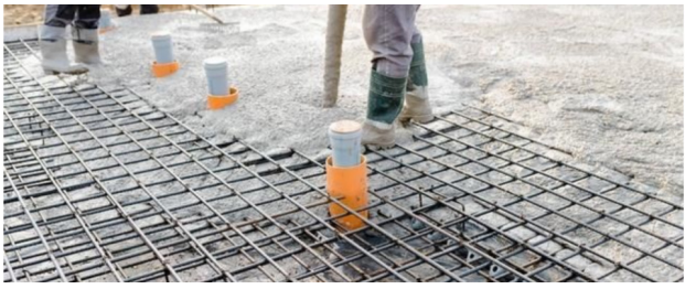
图2 现浇混凝土施工
