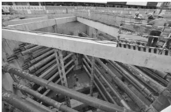
图1 基坑支护
