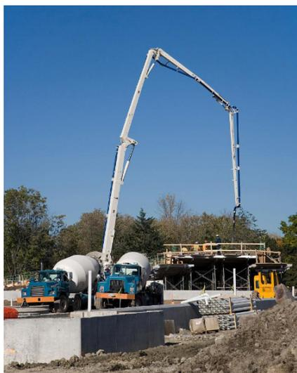
图1 泵送混凝土浇注
