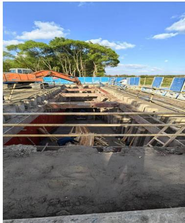
图3 A02#工井基坑现场图
