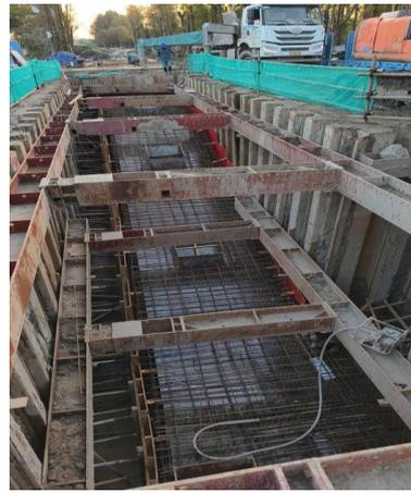
图2 A01#工井基坑现场图
