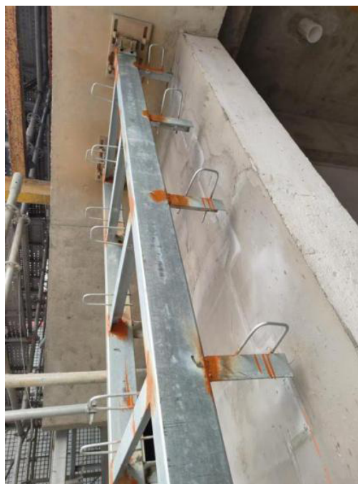
图 4 清水砖钢龙骨实物图
