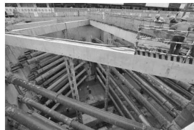
图 1 深基坑支护
