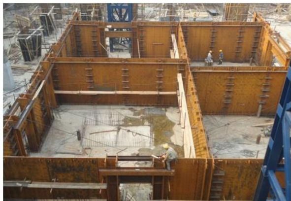
图 1 钢板剪力墙示意图
