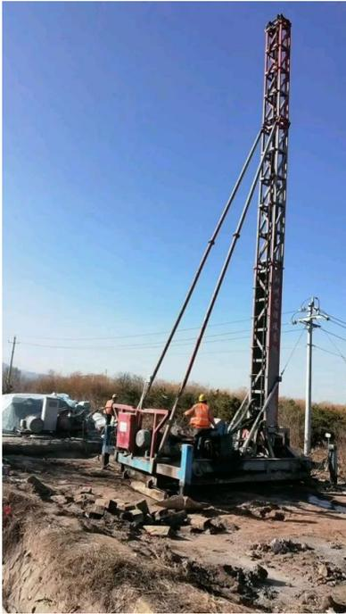
图 1 水泥搅拌桩施工示意图
