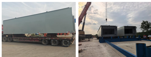
图 2、钢箱梁运输、二次拼装
