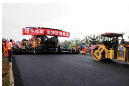
沥青路面摊铺施工
