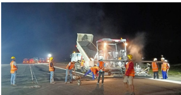
图 1 沥青罩面加铺施工
