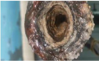
图 1 注水管道结垢腐蚀情况
