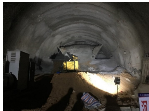
图3 旋喷桩试桩施工
