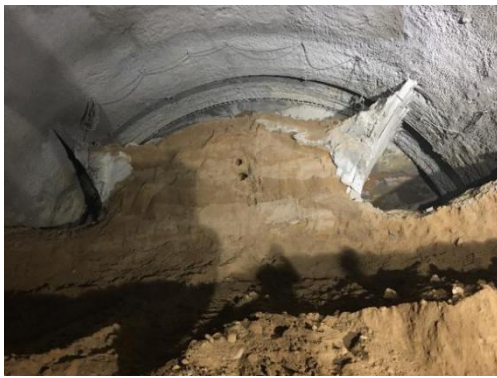
图2 现场地质及施工过程照片
