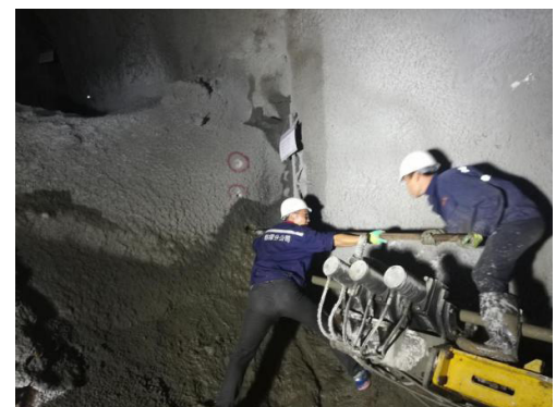
图5 水平旋喷桩施工
