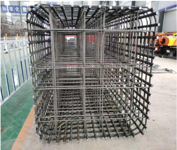
图7 墩柱钢筋场加工成型
