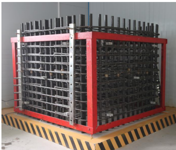
图6 墩柱钢筋加工胎架
