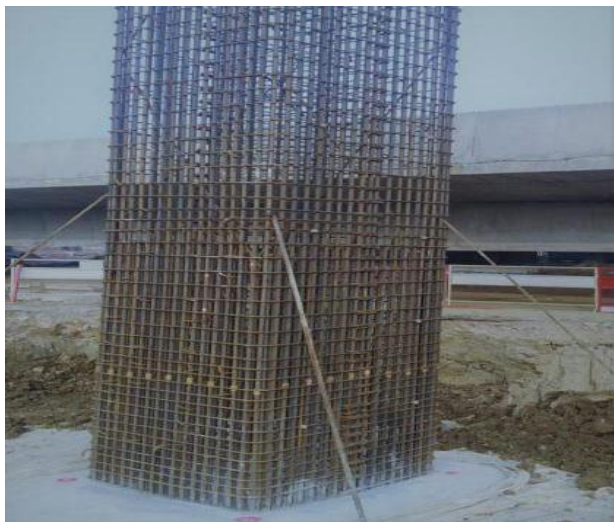
图9 墩柱钢筋四角加固
