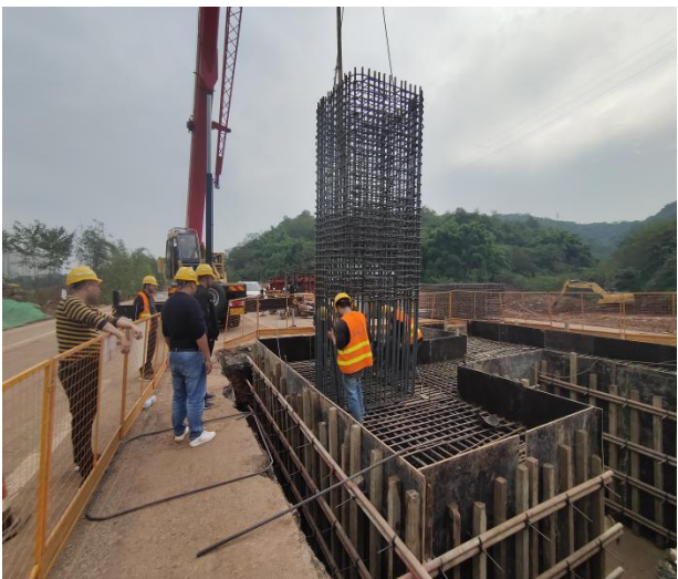
图8 墩柱整体吊装
