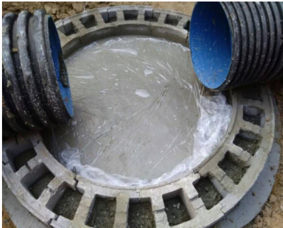
图 2 现浇混凝土检查井
