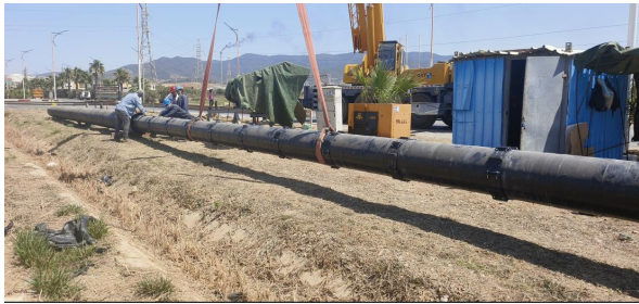
图2 内外套管安装
