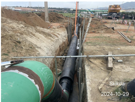
图3 埋地管道安装到位
