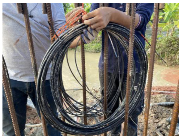
图 2 安装光纤的钢筋笼成品
