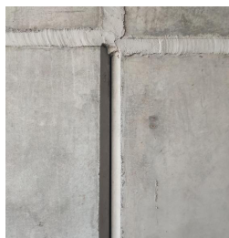
图1 预制外墙板水平缝和竖缝
