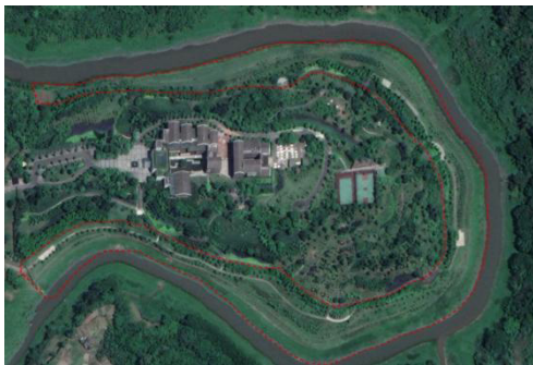
图3 2017年4月整体施工完成后航拍图
