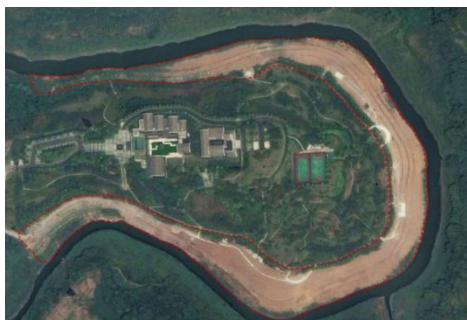
图2 2016年8月道路与护岸基础工程施工航拍图
