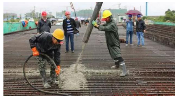
图 1 混凝土浇筑
